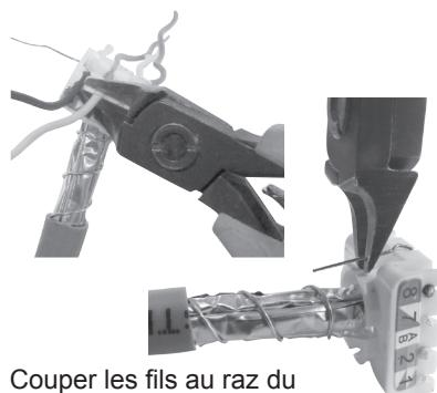
Couper les fils au ras du passe-fils et couper le drain\*.
